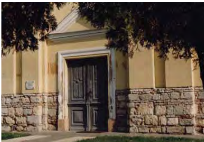
15. Az 1822–1824 között emelt Vártemplom nyugati homlokzata 1994-ben. A vakolattól megtisztított lábazatában jól láthatóak az uralkodó dzsámiból származó faragott kövek és téglák. Irás Mátyás felvétele
