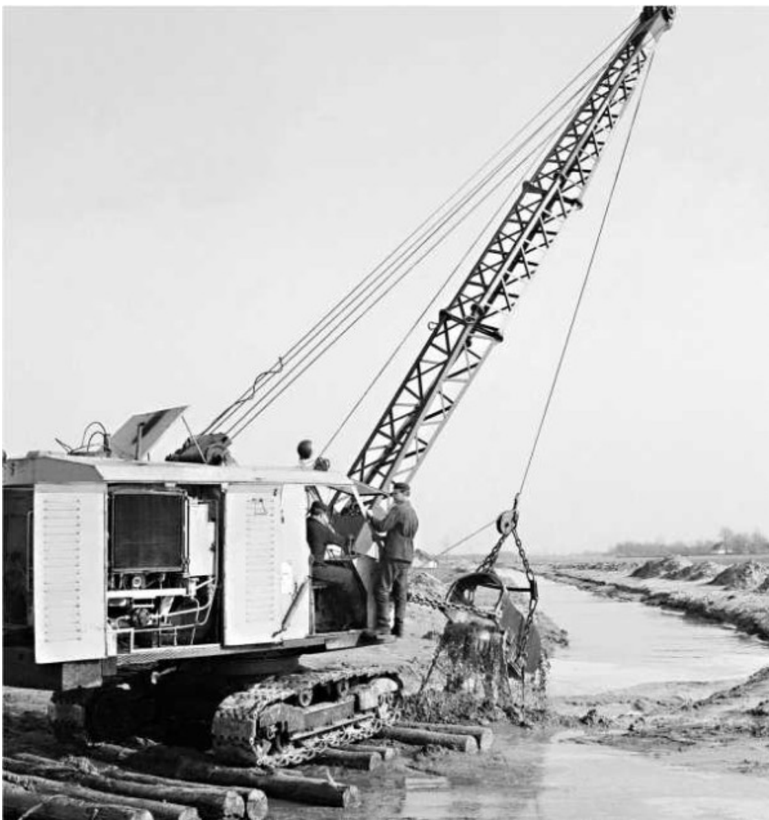
Belvízelvezető-csatorna építése a Homokhátságon 1965-ben. Forrás: MTI Fotó / Fehérváry Ferenc
