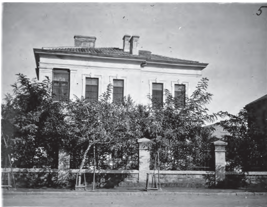
Bild 5 das Konsulatsneben- gebäude
