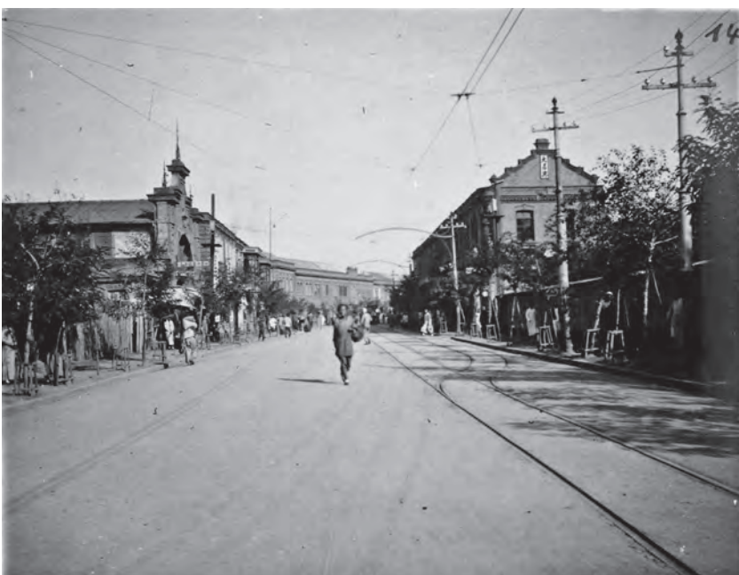
Bild 14 zeigt die Hauptstraße nach Überschreiten der Drehbrücke; links ist die Markthalle der Hotungbaugesellschaft, rechts die Mauer des Konsulargartens ersichtlich.
