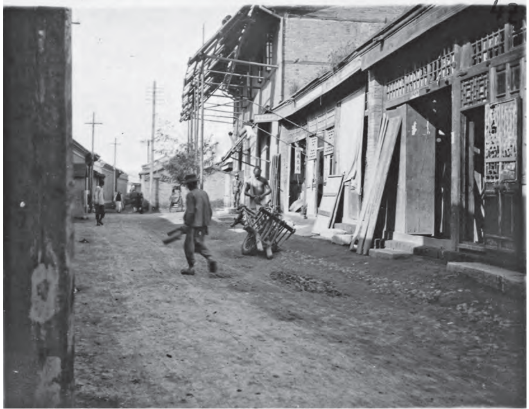
Bild 47 zeigt das Munizipalitätsgebäude der Niederlassung mit einem Mattenverbau (vide auch Bild 22).
