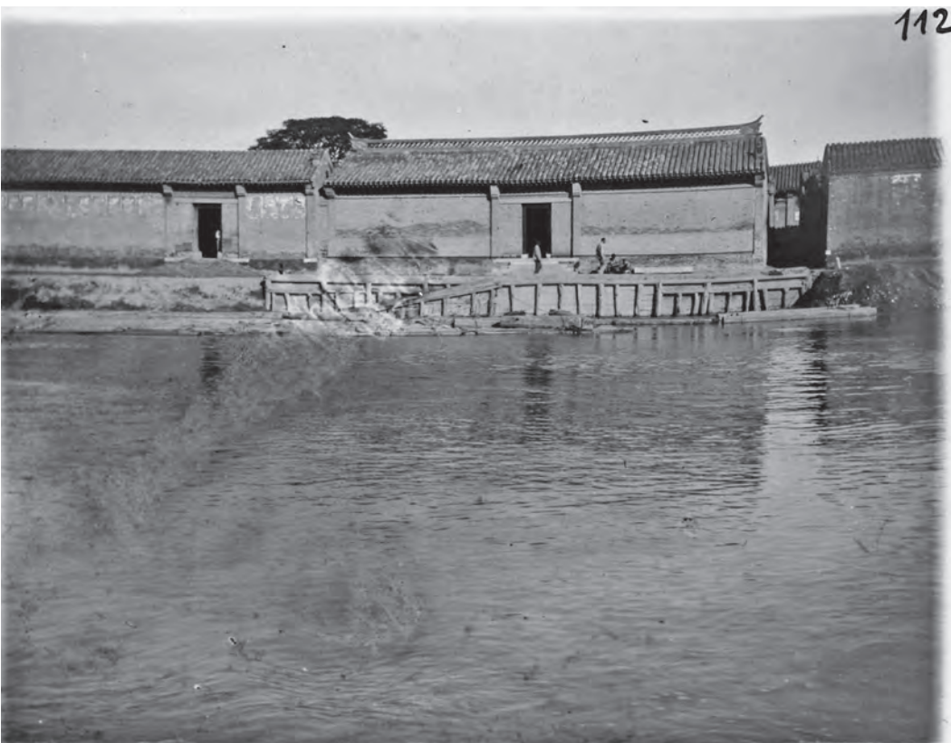
Bild 112 zeigt einen auf Bild 98 & 99 ersichtlichen Teil der Uferfront von der gegenüberliegenden Flußseite aus; das chinesische Haus hinter der Holzkonstruktion der Uferfront ist ein größeres Getreidegeschäft.
