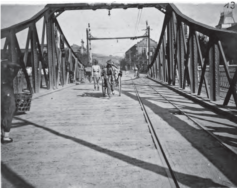
Bild 13 zeigt die Hauptstraße von der Mitte der Drehbrücke aus gesehen; rechts oben in der Ecke des Bildes erblickt man das Türmchen des Konsulatsgebäudes.
