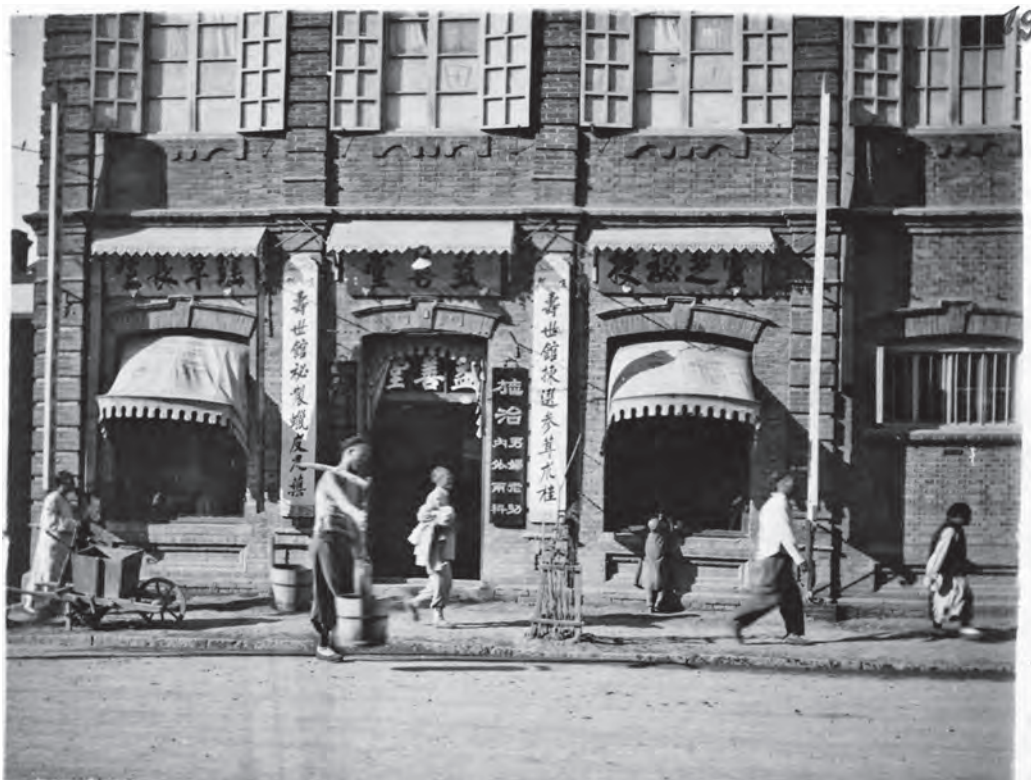
Bild 19 Im ersten Stock des selben Hauses der Apotheke befinden sich die Lagerräume eines chinesischen Pfandhauses.
