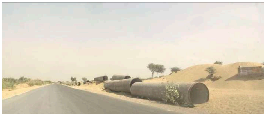
133. kép. Épülő csatorna a Thár sivatagban
